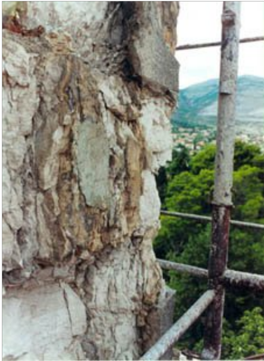
Требиње, Саборни храм (балкон, јужна и северна фасада): оштећења на камену
