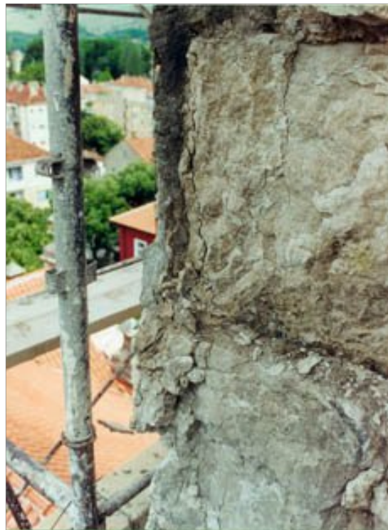
Требиње, Саборни храм (балкон, јужна и северна фасада): оштећења на камену
